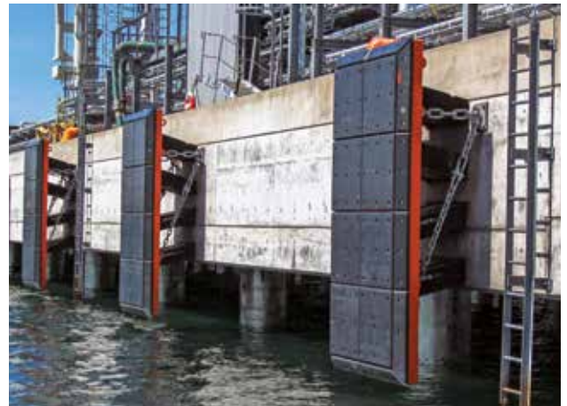
Ethanol Jetty | Stenungsund | Sweden
