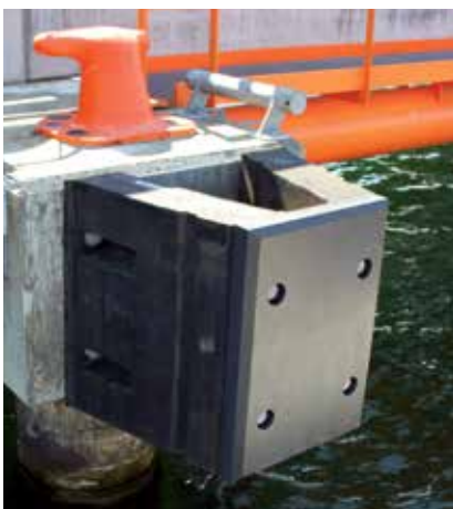
Ethanol Jetty | Stenungsund | Sweden
